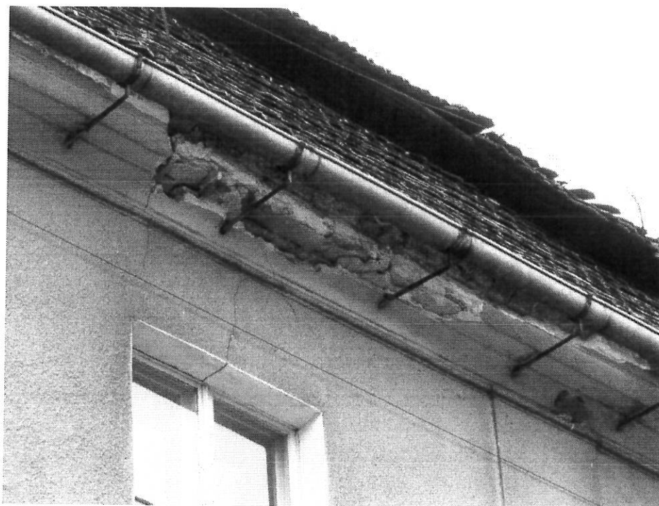
Fot.2. Ubytki na ścianie południowej (aut. Szymon Wójcik).
